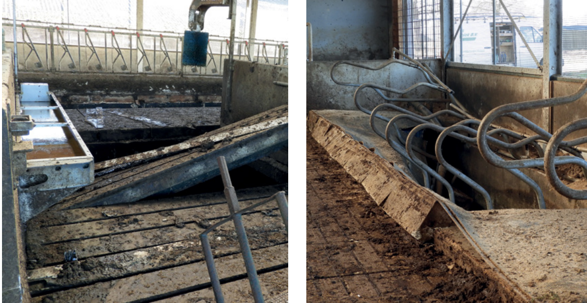
Figuur 16: Stalvloer na een gastmestexplosie. Als gevolg van het mengen van de mest ontstond ter hoogte van de vloer een explosief mengsel. In combinatie met een ontstekingsbron leidde dit tot een steekvlam met daaropvolgend een explosie. Door de explosie en drukgolf die hierop volgde, zijn vloerdelen ingestort en verschoven. Bij het ongeval kwamen 23 koeien om. (Bron: Brandweer Twente (foto's) en Omgevingsdienst Twente 126 )
