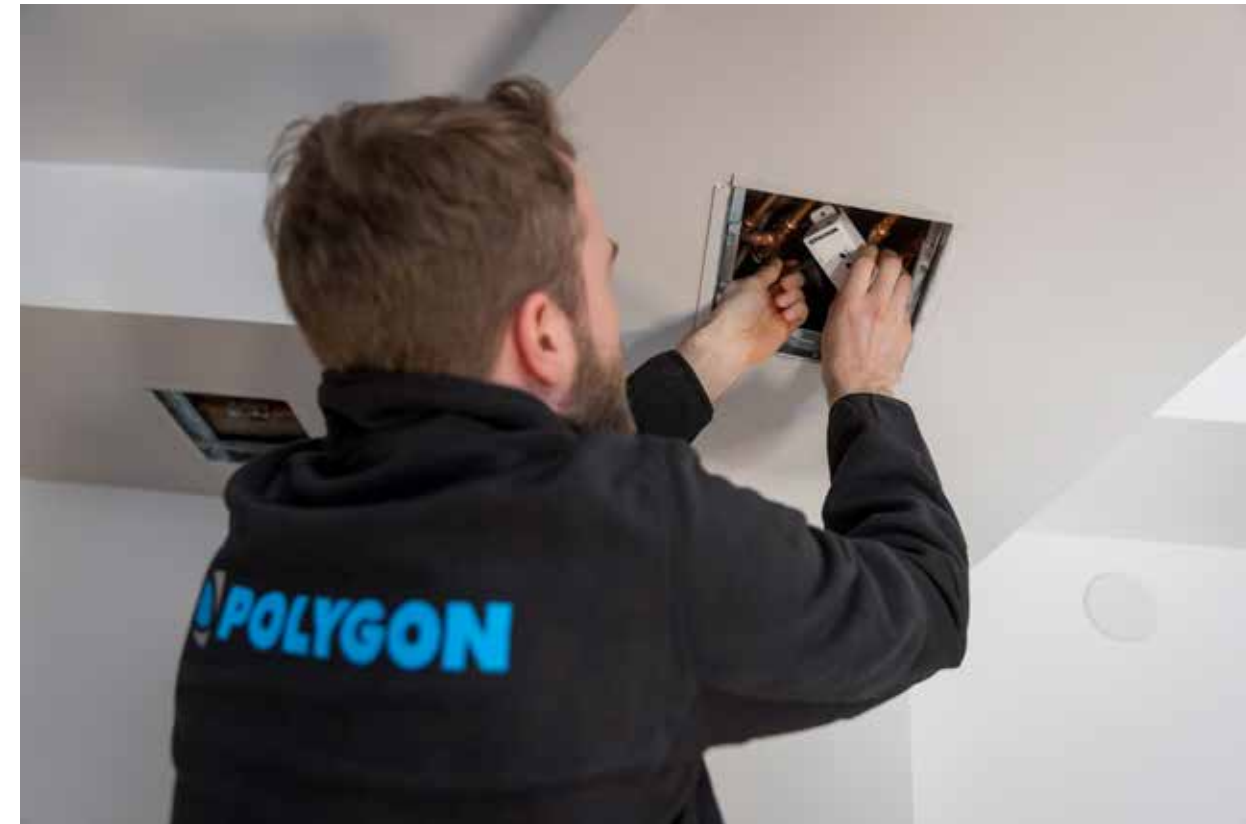
Een mooi voorbeeld van innovatie is de sensor die Polygon plaatst bij waterleidingen. Een dergelijke sensor kan waterschade voorkomen.
