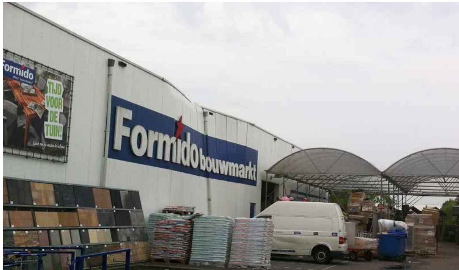
Een hagelbui op Tweede Pinksterdag in 2014 zorgde voor een dakinstorting van het Formido-pand in Steenbergse. Gelukkig was de makelaar binnen een uur na de melding van de schade ter plaatse.
